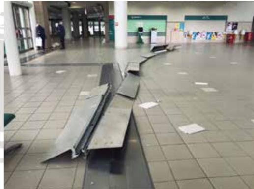
9. 5階の天井から天井部材(エキスパンションジョイント)が3階吹き抜け床まで落下
