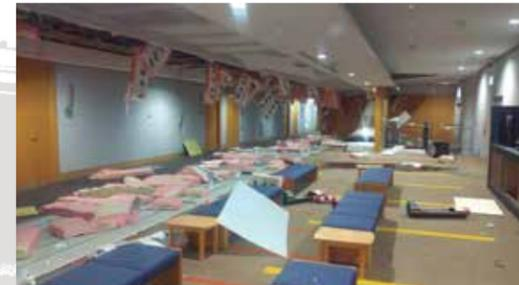
5. 6階来賓ロビーの天井及び断熱材が落下
