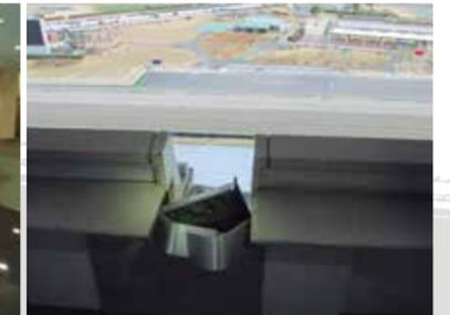
3. 6階業務エリアバルコニー及び天井(エキスパンションジョイント)破損及び落下
